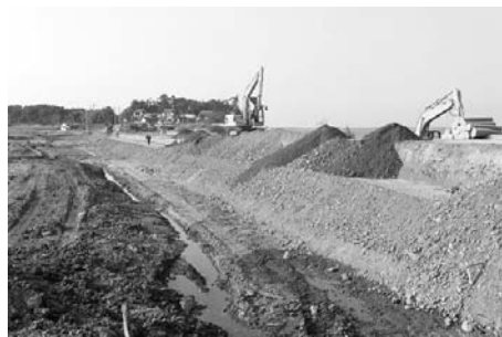
急ピッチで進められる堤防工事
